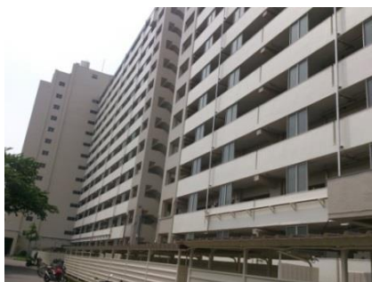
建物外観（共用廊下側）
