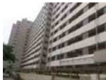
建物外観（共用廊下側）
