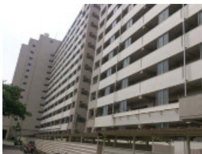
建物外観（共用廊下側）
